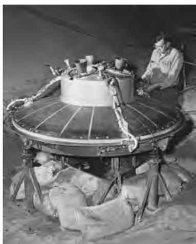
*Le bouclier thermique et le container des rétrofusées durant des tests*
